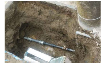
交換後の配管
